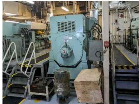
Génératrice | Alimentation auxiliaire
